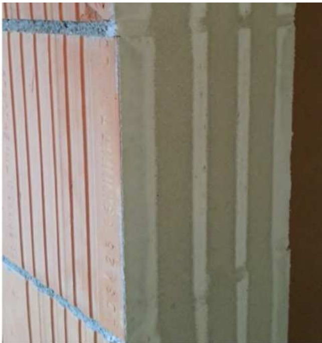
Вирівнювання отвору теплоізоляційним розчином illbruck PR005 – це перший етап для отримання щільного з'єднання між вікном та конструкцією будівлі
