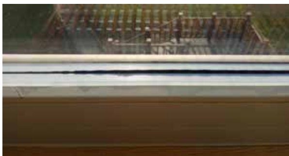
Приклад неприпустимого > 2 мм випинання бутила
