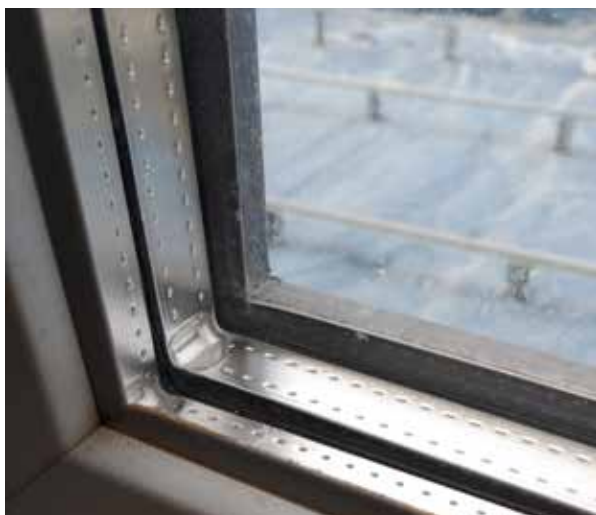
Приклад неприпустимого зміщення > 3 мм дистанційної рамки відносно одна до одної
